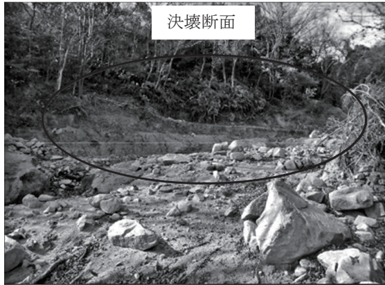
3 山下1号 堤体の状況（下流側から撮影）
