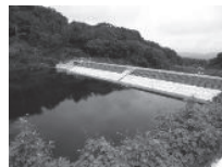
整備後のため池
