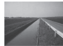
排水路の整備
