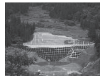
地すべり対策工事の完了
