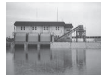
排水機場の整備
