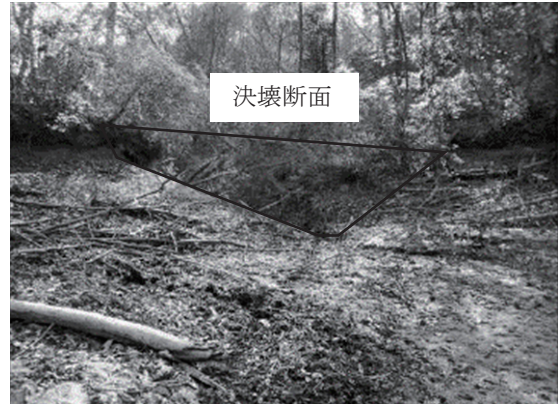
12 重迫下池（下流側から撮影）
