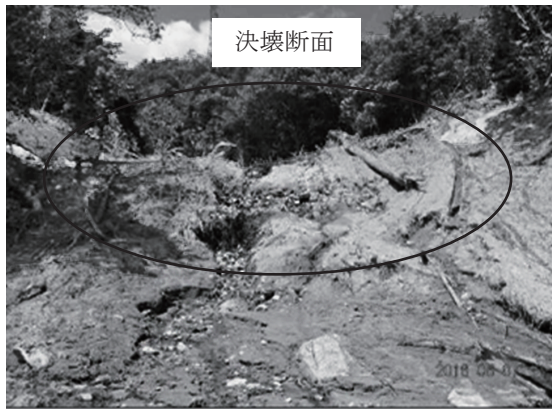
17 山の神2ため池 堤体の状況（下流側から撮影）
