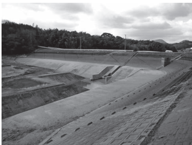
写真1 耐震補強工事（押え盛土）
