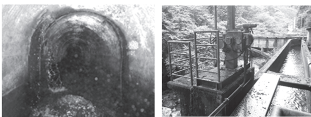
【道後南部幹線水路（隧道と用水路）】
