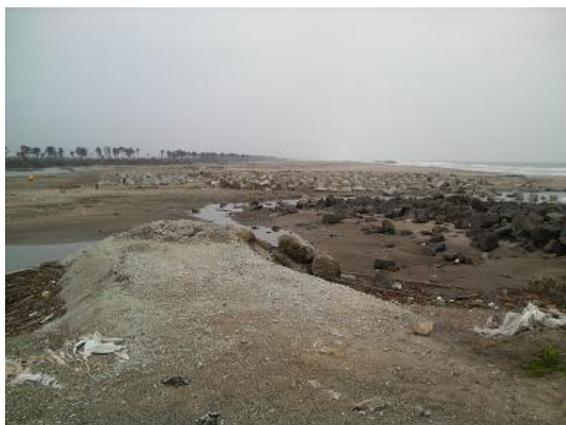
牛橋排水機場地の消波ブロック損壊
