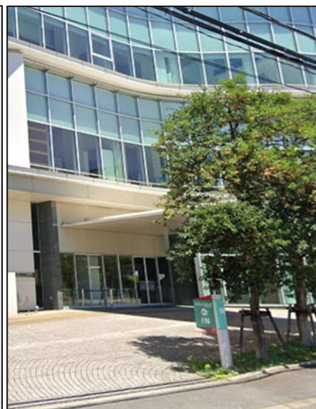
正面入口（建物東側）
