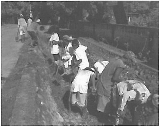
写真1－水利組合員参加方式による土砂上げ工事の実施
