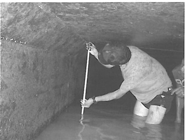
写真2－水路トンネル内で土砂上げ状況を確認する専門家
