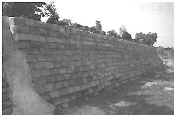
（写真2 設計・施工されたコンクリートブロック擁壁工法
