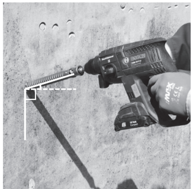
図5 コアビットを用いた削溝作業
